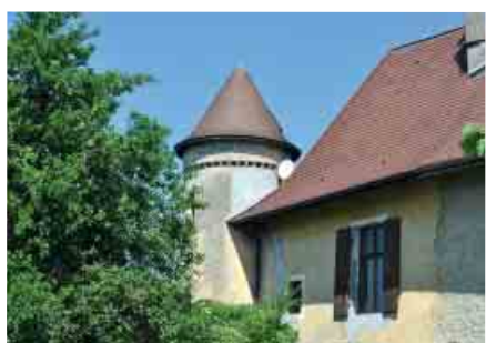
Tour ronde de défense, datant vraisemblablement du 13 ème siècle, récemment rénovée.
