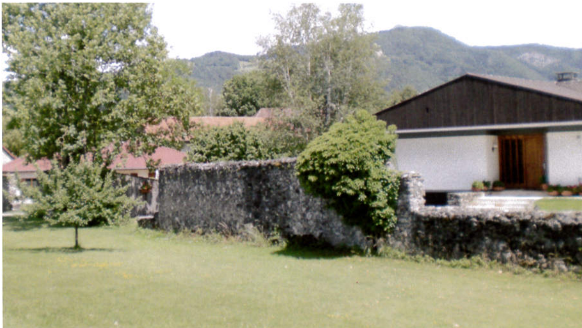
Mur de clôture à proximité du Château de Sonnaz
