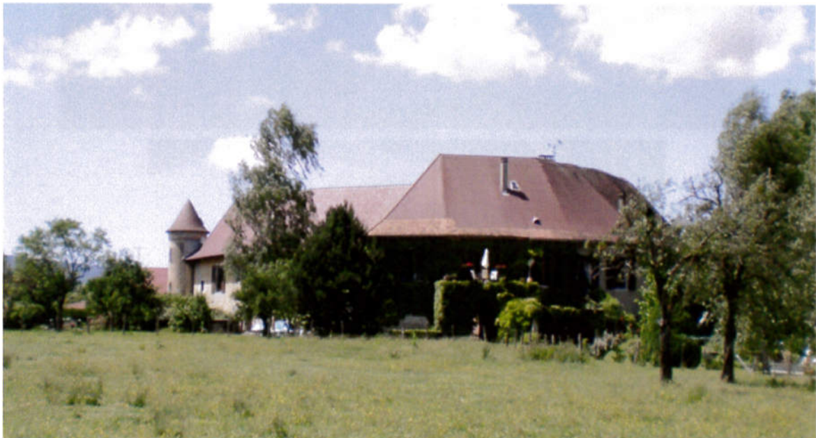
Vue de la façade Est du château
