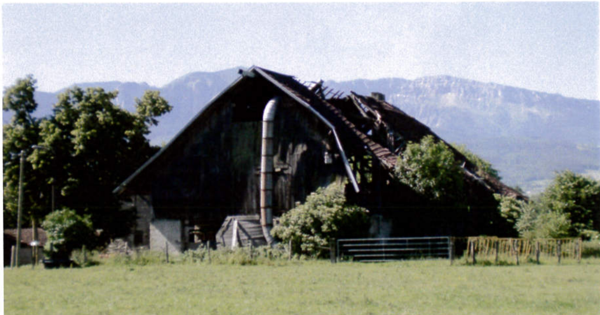
Vue de la façade nord de la bâtisse correspondant à la grange
