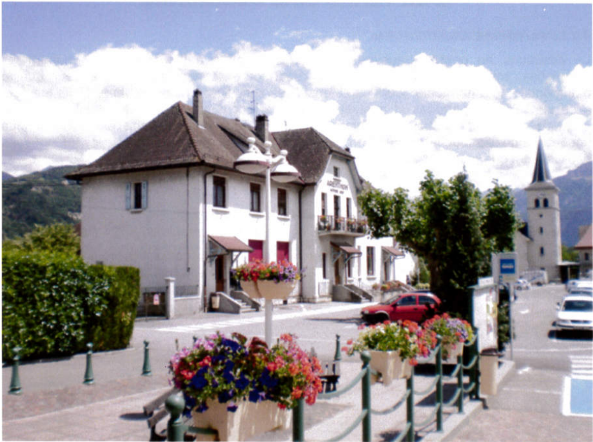
Vue de l'ancien bâtiment de l'école du chef-lieu
