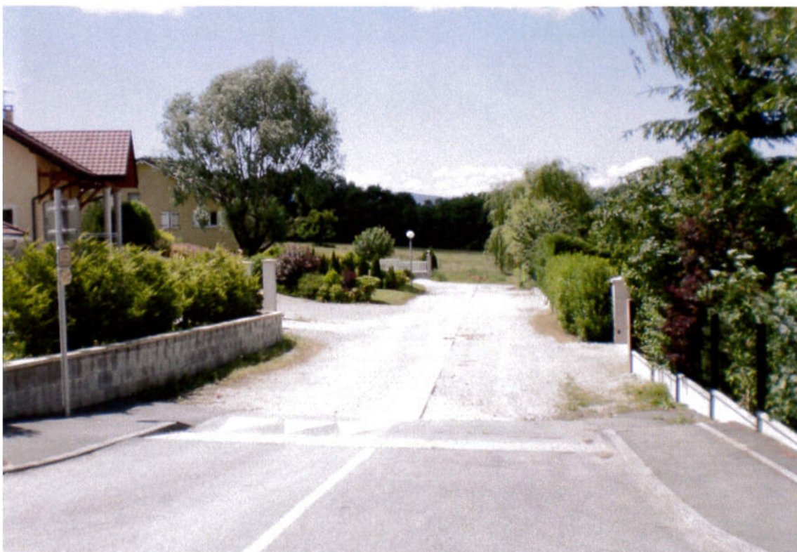
Voie privée inachevée dans un lotissement du chef-lieu
