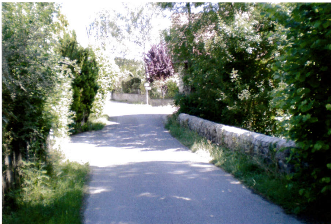
Murs de clôture au lieu-dit « Sur Berny »
