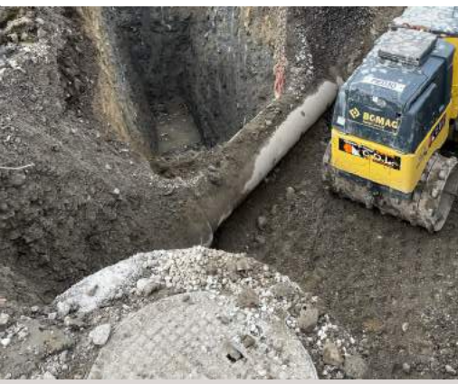
Installation d'une pompe de relevage pour les eaux usées.
