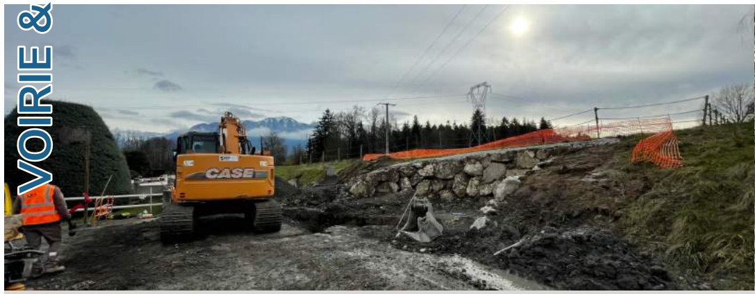
Vu l'envergure des travaux réalisés, le tapis de la route sera entièrement refait
