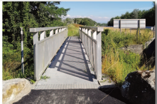
Ré-aménagement des passerelles sur le Foron et sur le Nant de Sion
