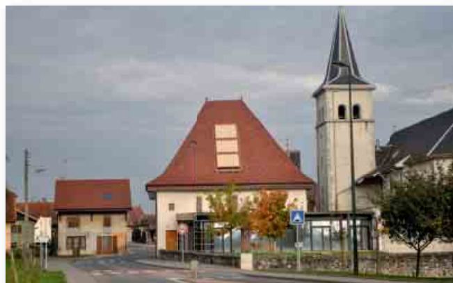
Entrée du village avec réseau aérien
