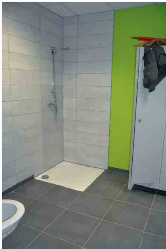
Mise aux normes des locaux du Service technique (réalisation du Service)
