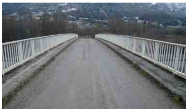
Vue intérieure du pont actuel.
